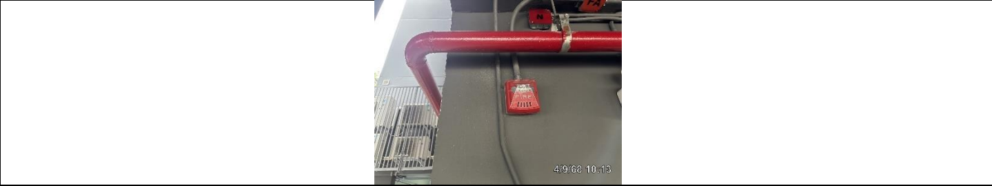
รูปที่ ฝ7.50 เครื่องแจ้งเหตุด้วยเสียง (Fire alarm speaker)
